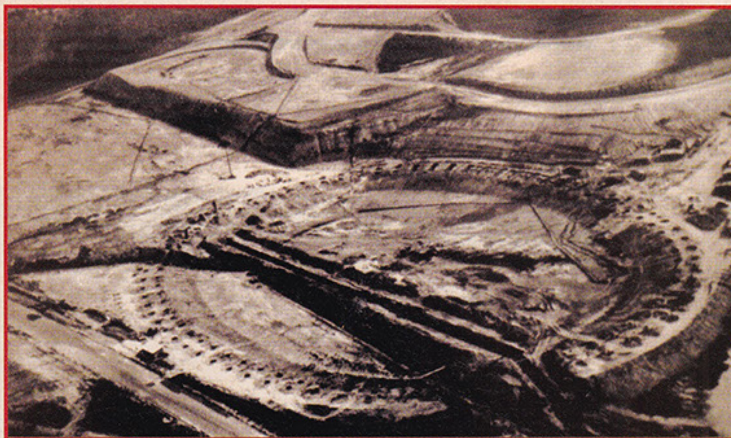
OBRAS DE FUNDAÇÃO E DA GALERIA QUE CANALIZOU O CÓRREGO QUE ATRAVESSA O CAMPO LONGITUDINALMENTE
