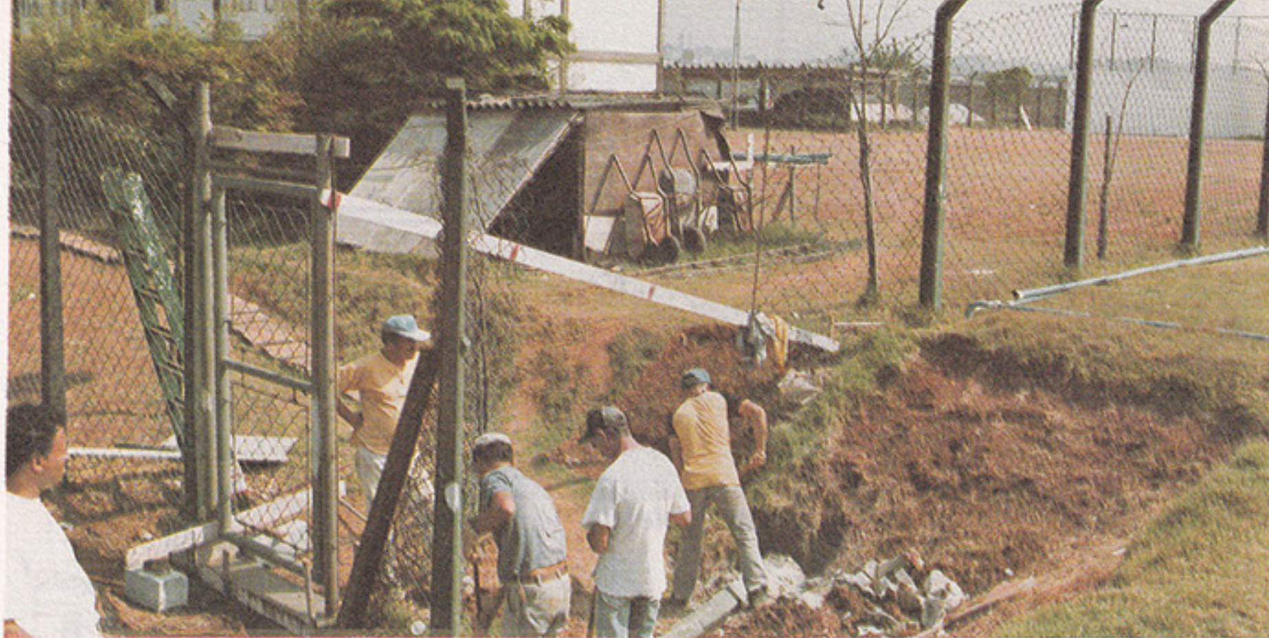
Centro de Treinamento: obras o tempo todo.
