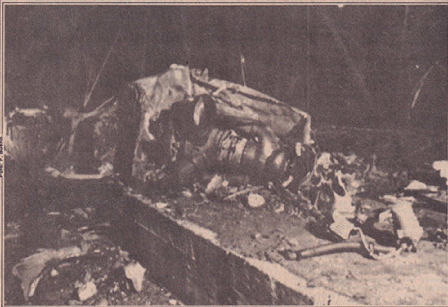
No pátio do presídio, os restos do helicóptero.
