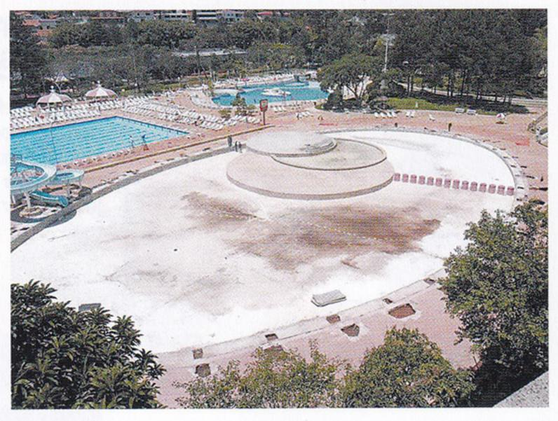
A Piscina Oval está passando por uma reforma ampla, na qual todos os tubos de retorno de água tratada estão sendo substituídos, com uso dos modernos tubos PEX.
