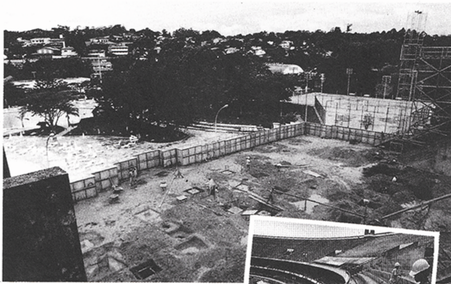
De um lado, obras da fundação do bloco das piscinas aquecidas, para os associados; de outro, obras no estádio, para os torcedores.
