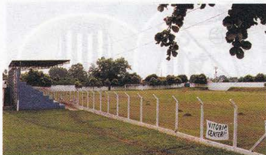
Estádio Municipal em reformas.
