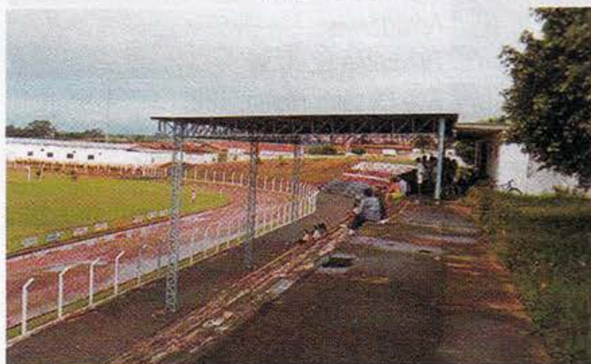
Vista parcial do Estádio Josephino de Carli.
