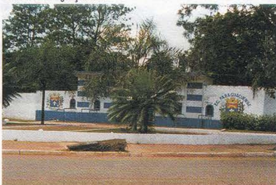
Estádio do Paraguaçuense.
