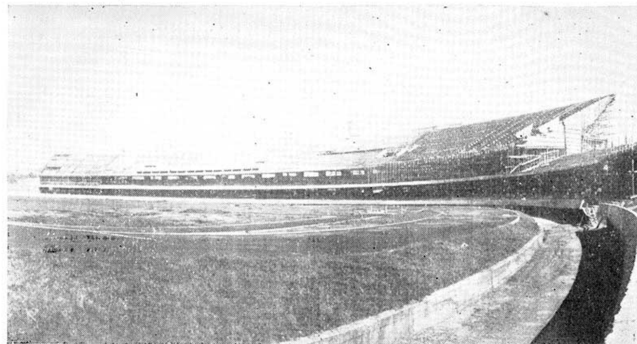
Aspecto das obras em fins de 1958
